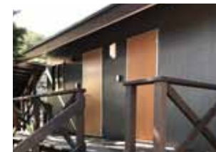
山梨県北杜市八ヶ岳青年小屋
