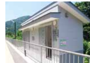
兵庫県香美町餘部鉄橋「空の駅」
